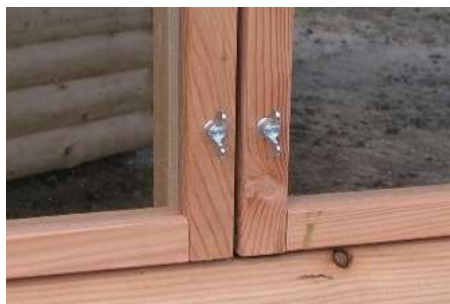
Mod en merpris på 300,- kan vinduerne monteres med fløj skruer, og kan af- og påmonteres uden brug af værktøj (ikke egnet hvor der er mange "pilfinger")
