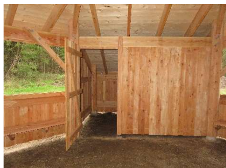
Tilbygning lukket 4 sider, med hængslet dør mod bålhytten. Ingen gulv. Egnede som aflåseligt opbevaring, redskabsskur el.lign.
