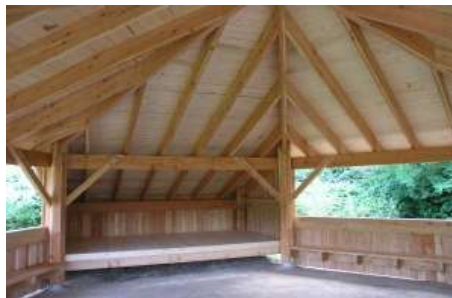
Påbygget shelter, med fast gulv i høvlede brædder.
