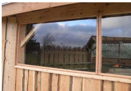
Vinduerne er som standard fastskruet med alm. træskruer og kan af- og påmonteres med en alm. skrutrækker torx 20
