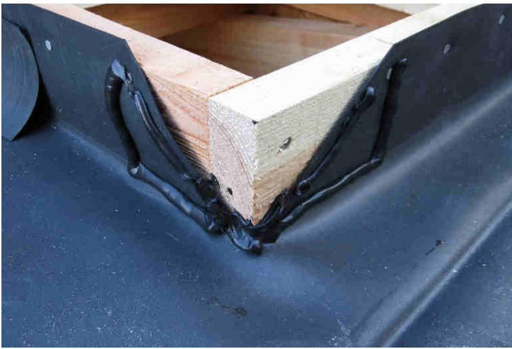
Fugemasse påføres, rigelige mængder især nederst på hjørnet
