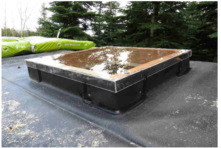
Gummidugen skæres af glat med overkant ramme. Ruden monteres med de 4 skruer med gummiskiver.
