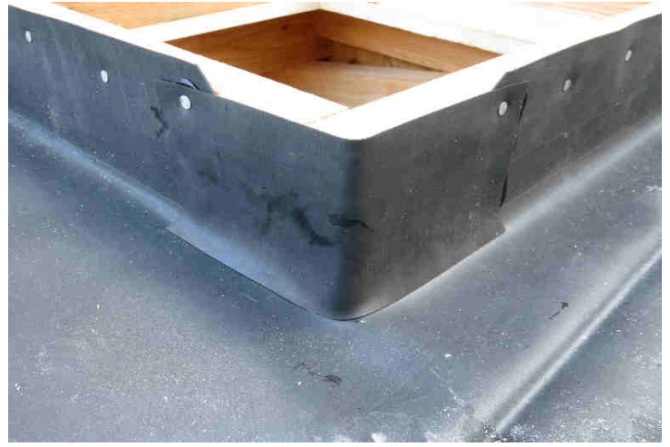
De medleverede gummistykker trykkes fast i fugemassen og fastgøres med nogle få papsøm.
